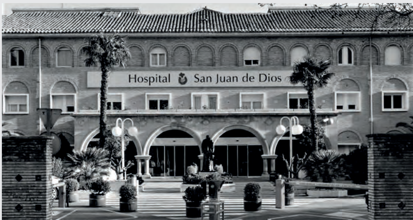
Hospital de San Juan de Dios de Zaragoza.
